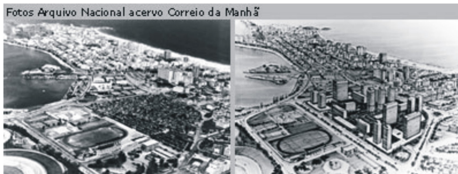
Figura 2. As fotografias mostram, do lado esquerdo a Favela da Praia do Pinto na década de 1960 e do lado direito o projeto que, na época foi idealizado para o local da favela. Atualmente, o local é ocupado por um conjunto de prédios que formam a chamada Selva de Pedra.
